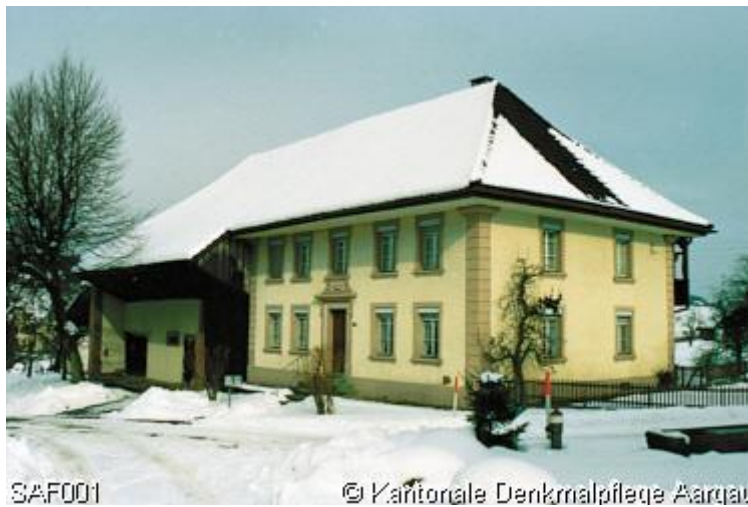
Abbildung 4: Kantonales Denkmalschutzobjekt: Bauernhaus an der Bärengasse 1 (Quelle: Kantonale Denkmalpflege Aargau)
