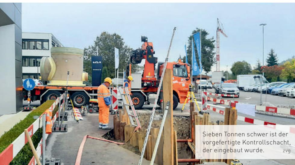
Sieben Tonnen schwer ist der vorgefertigte Kontrollschacht, der eingebaut wurde.
