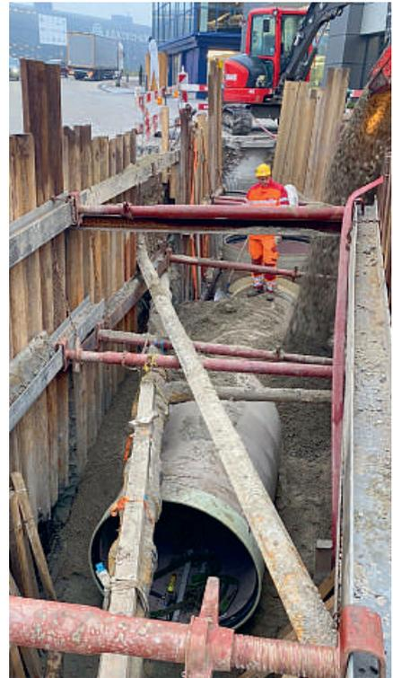
Die glasfaserverstärkten Kunststoff-Rohre für den Sauberwasserkanal werden eingebaut und mit Leitungskies eingedeckt.
